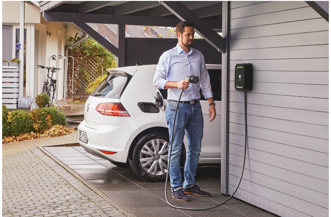
Bild 2: Ladeeinrichtung für Elektrofahrzeuge auf einem privaten Grundstück
