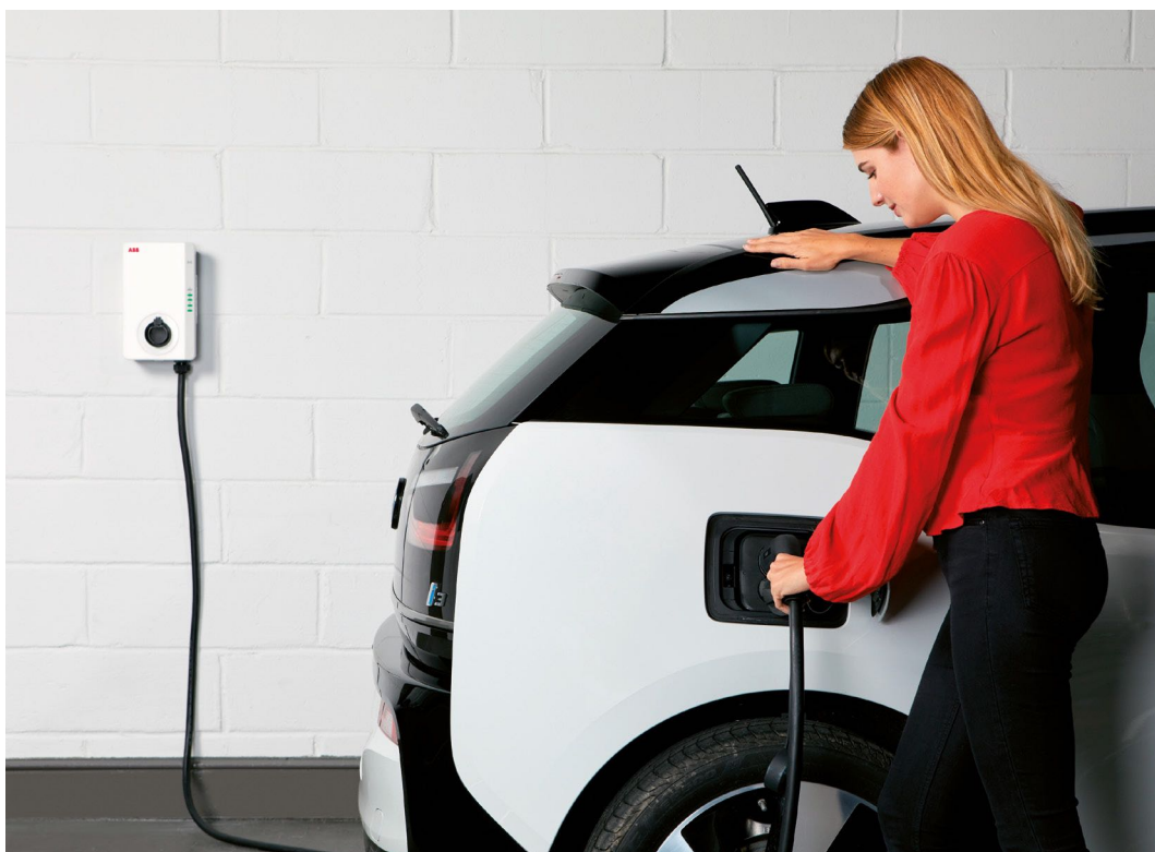
Bild 8: Ladeeinrichtung (Wallbox) in einer Garage
