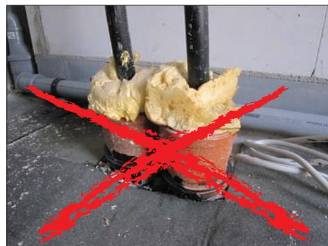
Regelwerke fordern, dass Gas-, Wasser-, Strom-, Telekommunikations- und Fernwärmeleitungen gas- u. wasserdicht in Gebäude eingeführt werden müssen!
